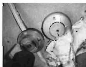
写真10 実験後のC室内住警器（煙式）（拡大）
