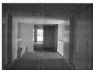
写真7 想定火災階廊下
