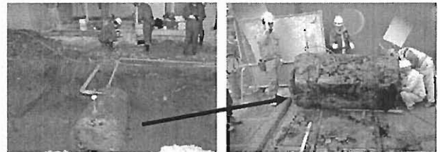
図11 廃油タンク及びタンク底部
