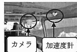
写真2 機器取付状況
