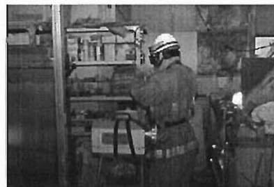
写真1 残火現場での検証
