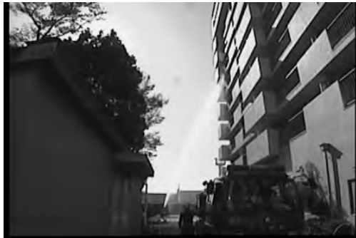
写真2 5階ベランダへ向けた放水状況
