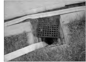
写真7 暗渠への放水状況
