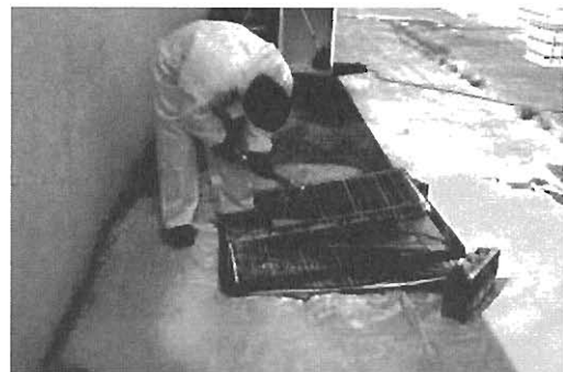
写真3 破壊途中のパネル
