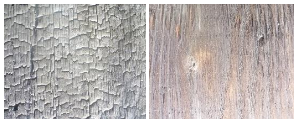
図12 実験後の床面合板の状況 （左図：発火あり、右図：発火なし）
