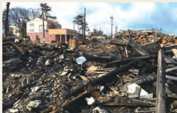
▲ 糸魚川市大規模火災の状況
