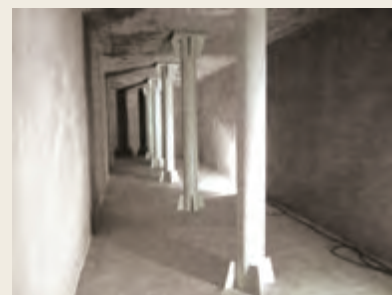
▲ 経年防火水槽の再生
