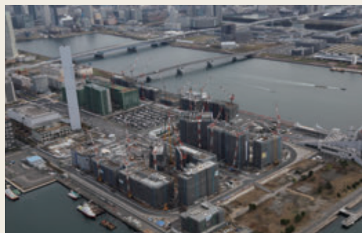
▲ 建設工事中の選手村
