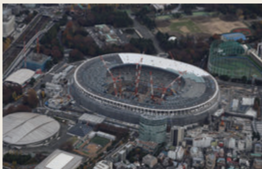
▲ 建設工事中の国立競技場
