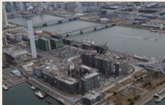
▲ 建設工事中の選手村
