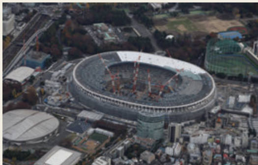
▲ 建設工事中の国立競技場
