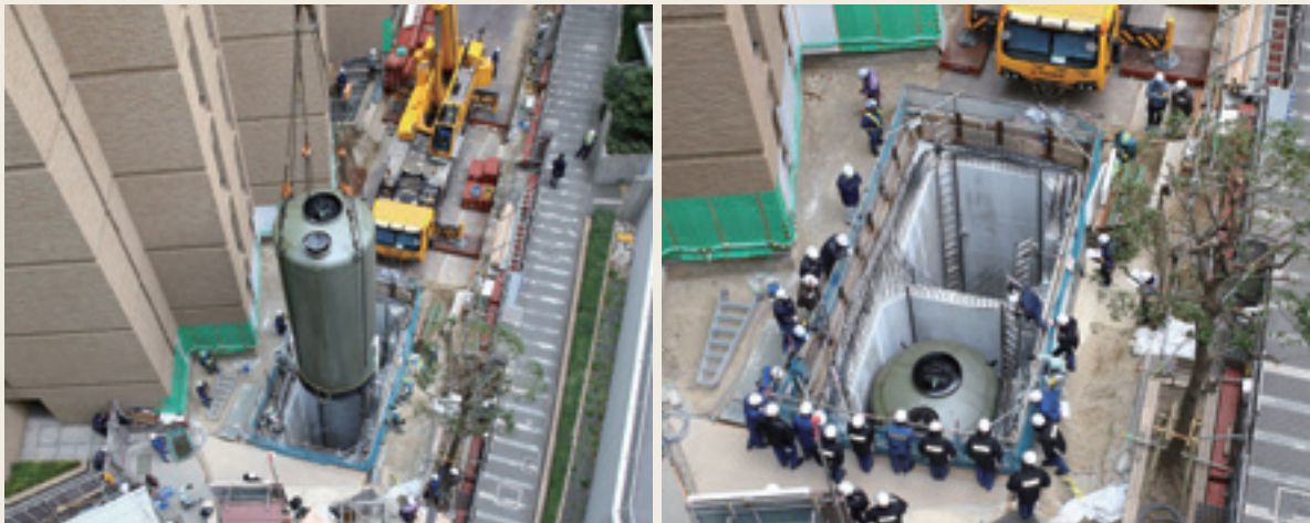
▲ 危険物タンクの設置時の状況
