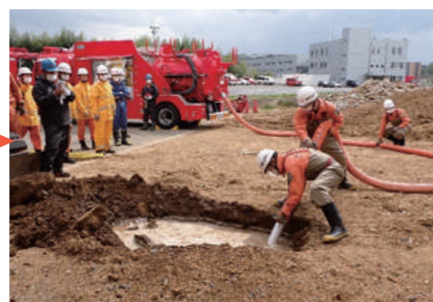
土砂吸引状況
