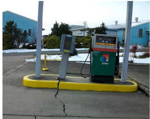
地盤面に亀裂が生じた状況
