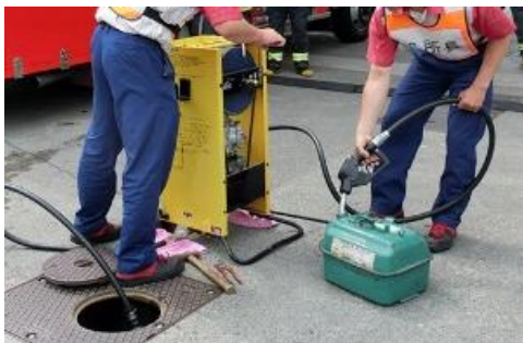
緊急用ポンプの使用例
