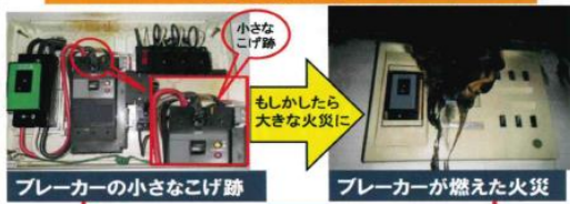
小さなこげ跡 / もしかしたら大きな火災に / プレーカーの小さなこげ跡 / プレーカーが燃えた火災
