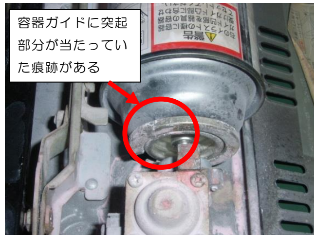
写真2-2 燃料ポンベ容器ガイドの状況
