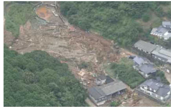
土石流による被害
