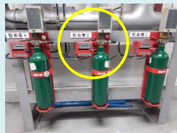
操作管に閉止弁を設置した例
