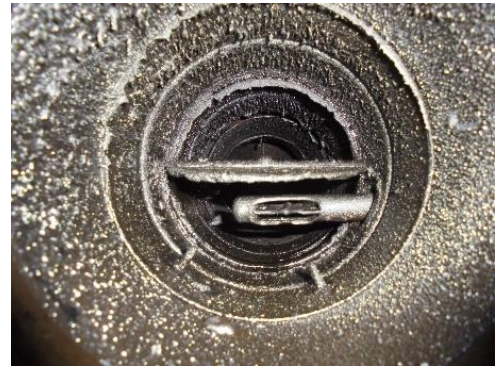
写真 5-17 店舗 E 防火ダンパー
