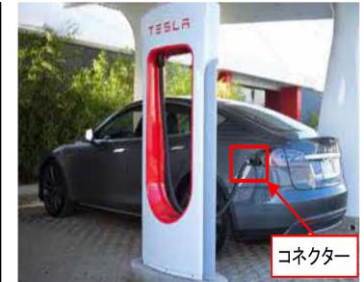
コネクター型急速充電設備の例※
