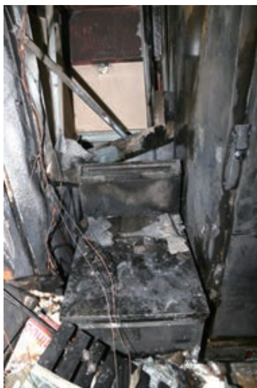
写真 6-3-5 ガスフライヤの焼損状況
