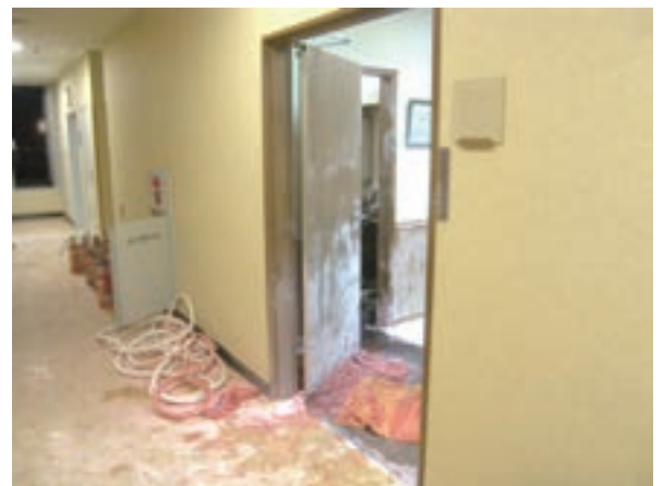
写真 7-2 補助散水栓の使用状況
