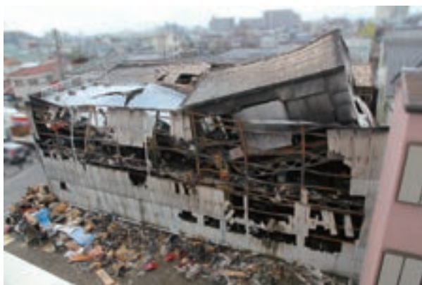
写真 6-8-3 出火した倉庫の状況
