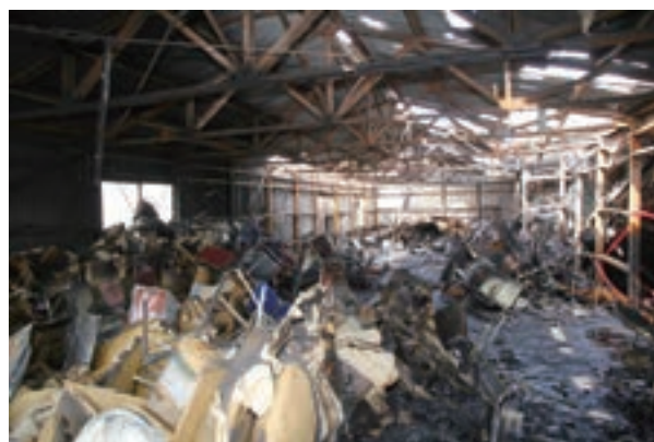
写真 6-8-4 2階部分の状況
