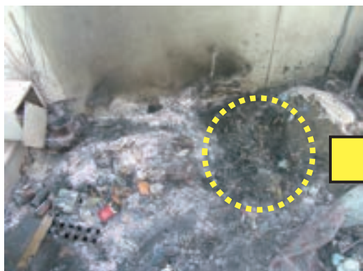
写真 6-12-2 ごみの焼損状況
