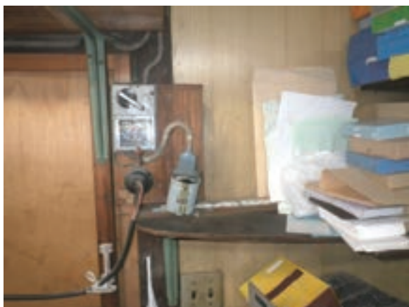
写真 6-7-1 作業所の状況
