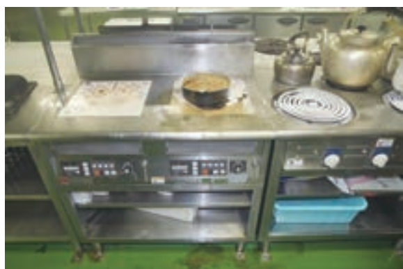
写真 6-5-3 出火箇所付近の状況
