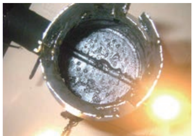
写真 6-2-5 防火ダンパーの作動状況 (作動し閉鎖している)
