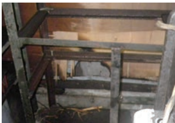
写真 6-7-4 ベニヤ板の状況
