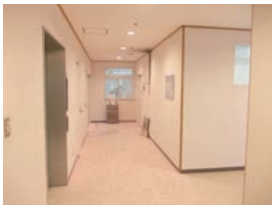
写真 6-5-1 出火箇所付近の状況
