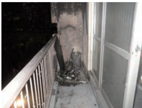
写真 6-9-5 窓ガラスの状況
