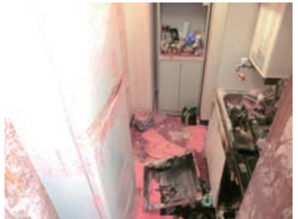
写真 7-1 給湯室の状況
