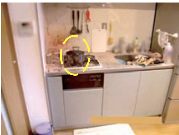
写真 3-1-1 台所の焼損状況
