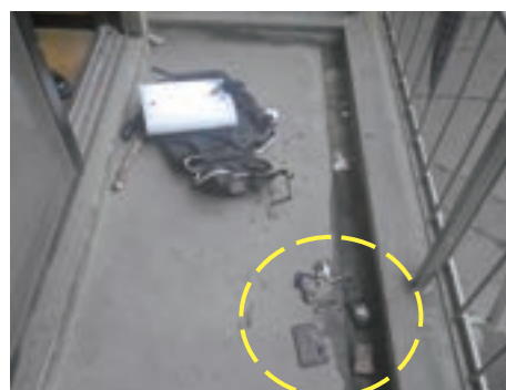
写真 6-6-3 ベランダの状況
