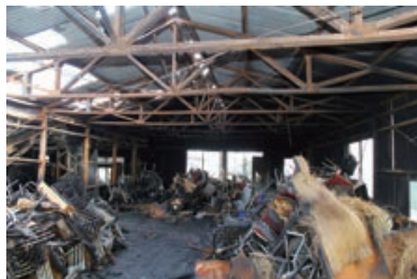
写真 6-8-5 2階部分の状況
