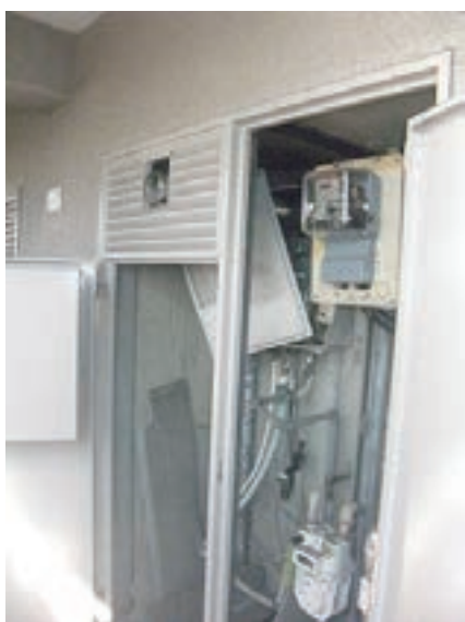
写真 3-4-3 パイプスペースの状況
