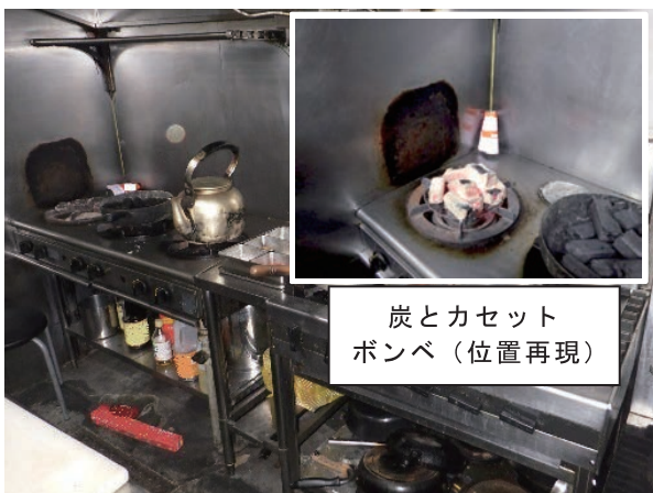
写真 3-4-1 大型ガスこんろ周辺の状況
