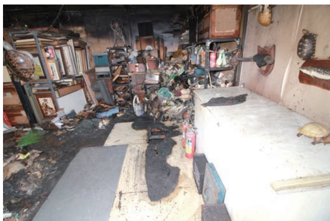
写真 6-8-1 倉庫内の状況
