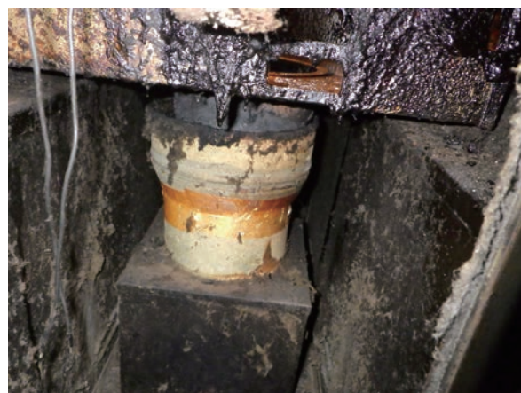
写真 6-2-5 防火ダンパーの設置状況
