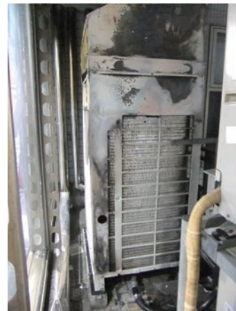
写真 7-1 室外機の状況
