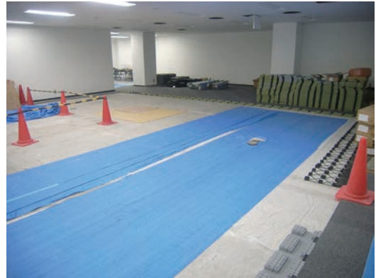
写真 5-2-1 内装工事中の状況
