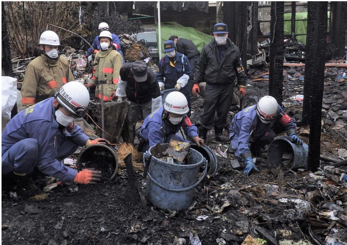
①建物火災の現場見分状況（3月）
