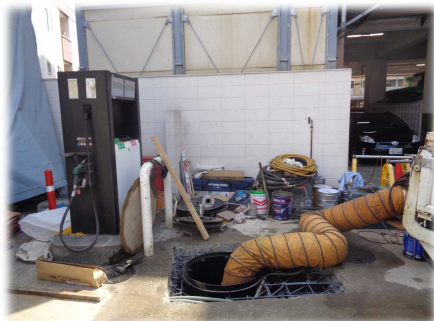
作業中は酸欠防止のため地下貯蔵タンク内に送風機で空気を送り続けます。
