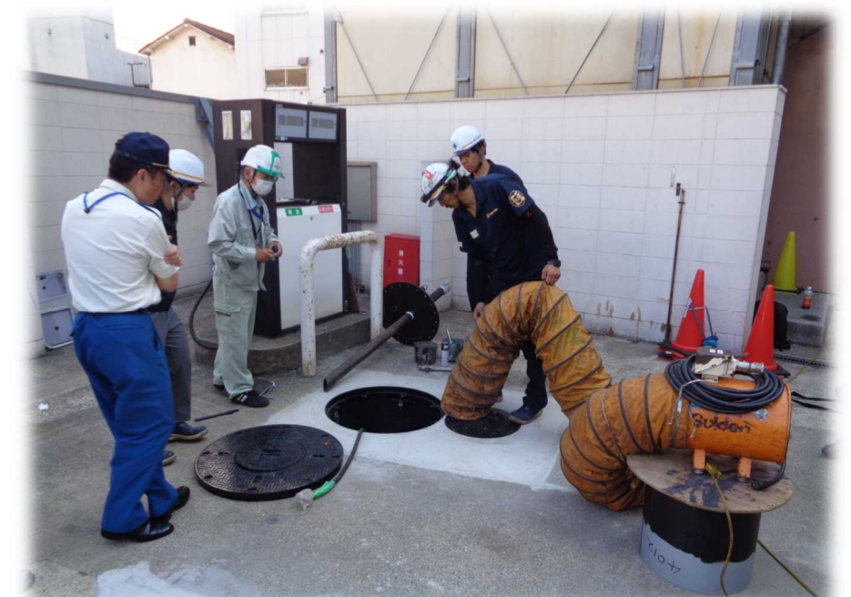
施工業者から地下貯蔵タンクについて教養していただきました。
