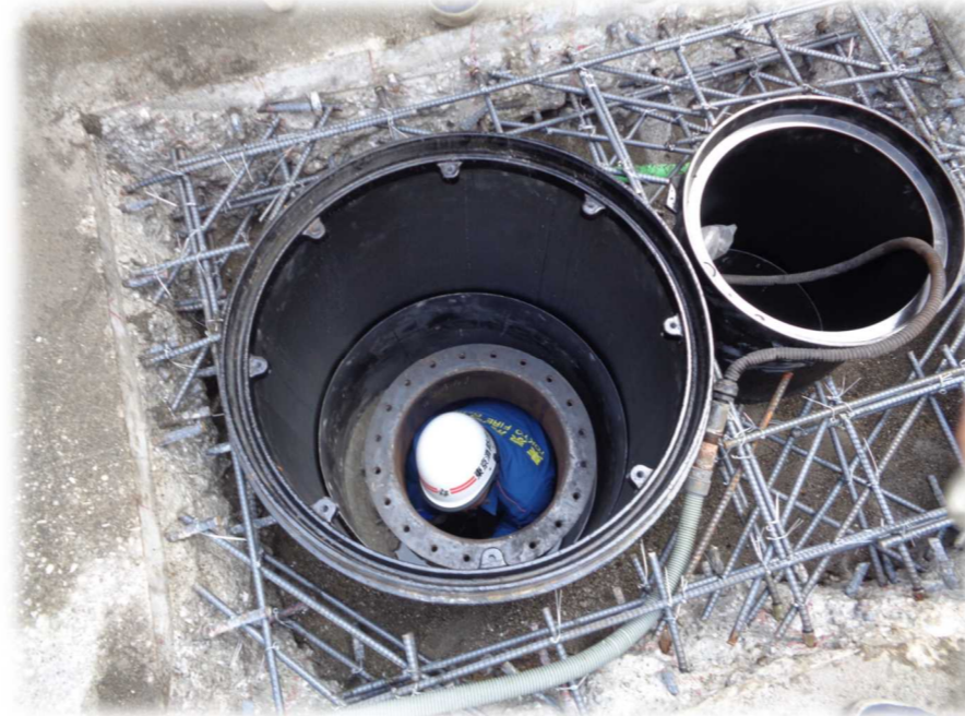
地下貯蔵タンク内確認中
