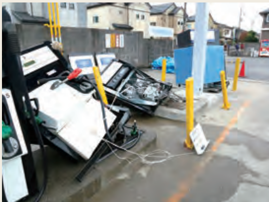
固定給油設備からの流出状況
