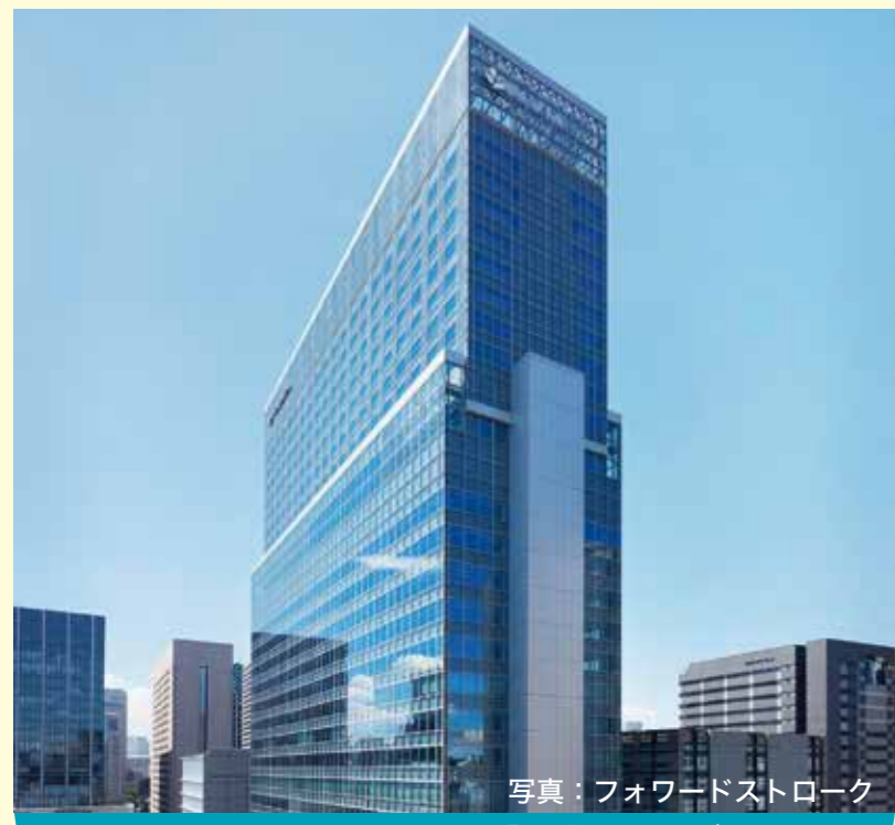
アーバンネット内幸町ビル・ THE BLOSSOM HIBIYA
