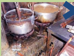
ガスコンロに油脂が付着した状態
