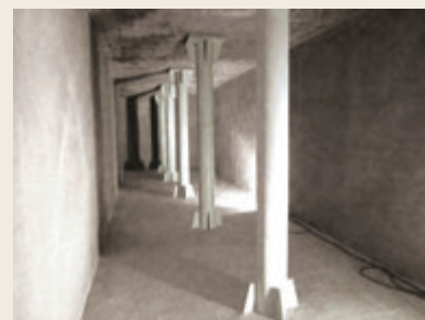
▲ 経年防火水槽の再生
