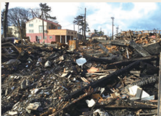
▲ 糸魚川市大規模火災の状況
