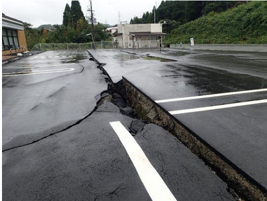
車両の出入に支障がある段差が発生した状況
