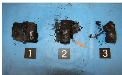
写真4 進相コンデンサの焼損状況
