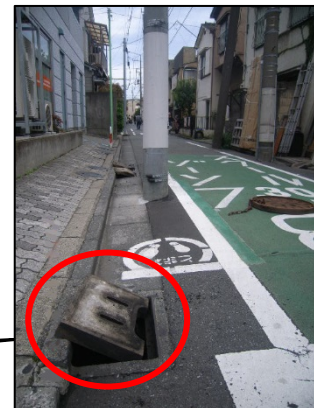
出火箇所周囲の状況
