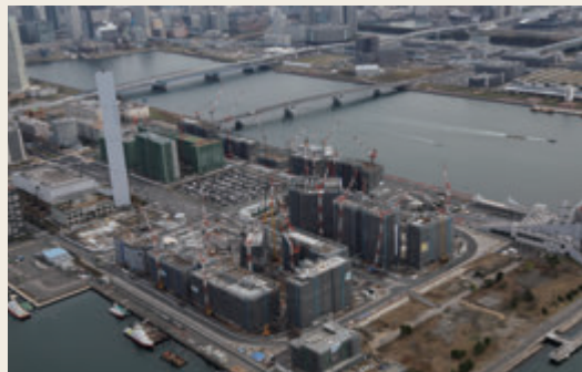
▲ 建設工事中の選手村
