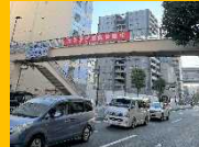
蔵前橋通り歩道橋
