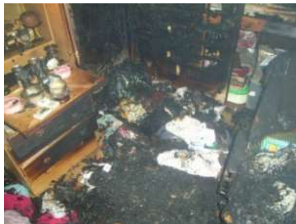
写真 1 - 2 復元した状況
