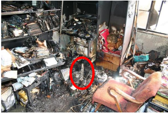
写真3-1 出火箇所の焼損状況
