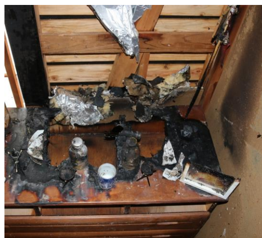
写真1-2 復元した状況
