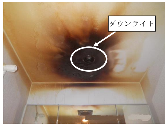
写真3-2 ダウンライトの状況
