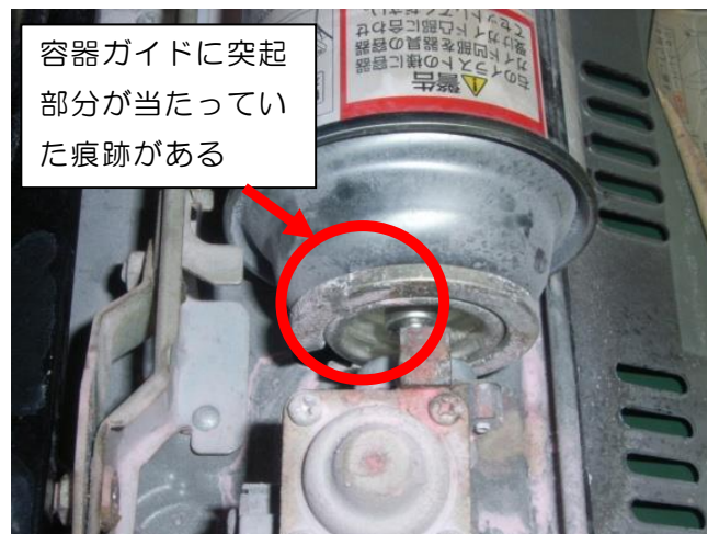
写真3-2 燃料ポンベ容器ガイドの状況
