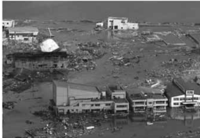
気仙沼港付近の津波・液状化被害状況
