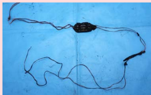
短絡により焼損した延長コード
